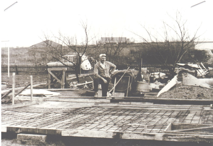
Die Bodenplatte ist Geschalt, der Betonmischer läuft.
